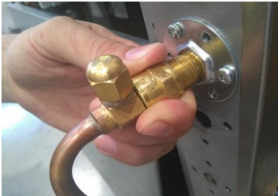
Image 4: Filetez les raccords à la main
